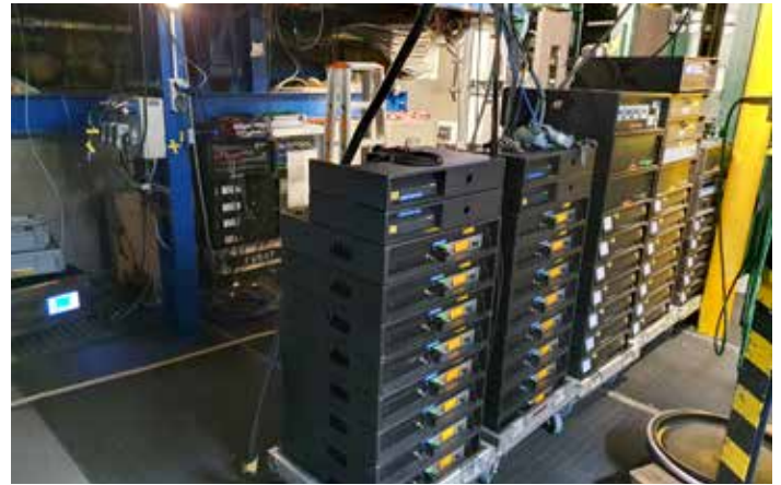
Raumakustik-Mainframe und Verstärker wurden in der Unterbühne eingerichtet
