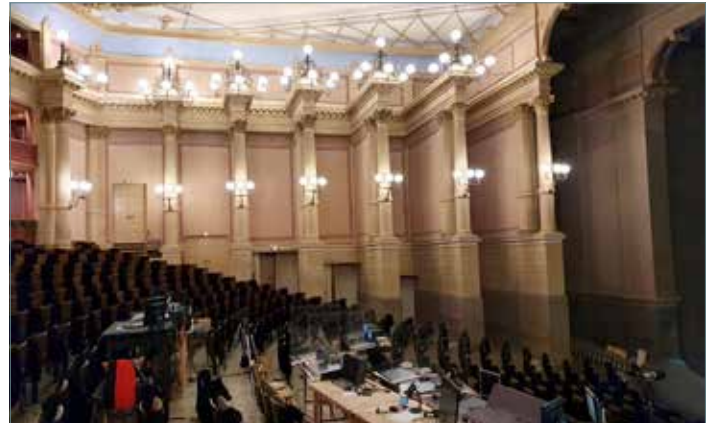
Zusätzliche Lautsprecher wurden im Zuschauerraum über den Eingängen installiert
